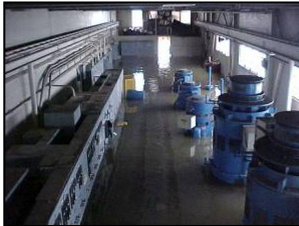
**Figure 19. Final Effluent Pumps**
