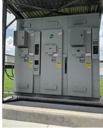
**New Automatic Switchgear**
